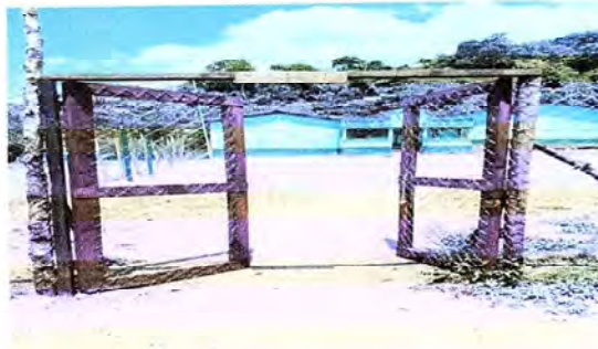
Foto 2: SUSTITUCION DE PORTON POR DETERIORO
