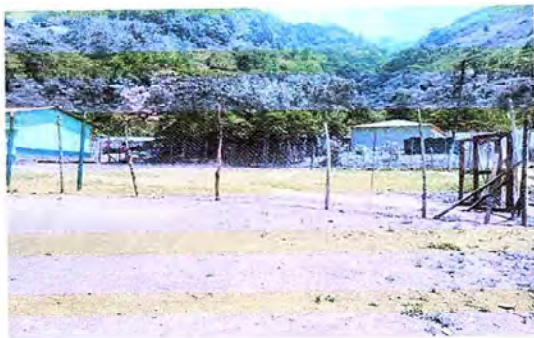
Foto 1: SUSTITUCIÓN AREA DERECHA
