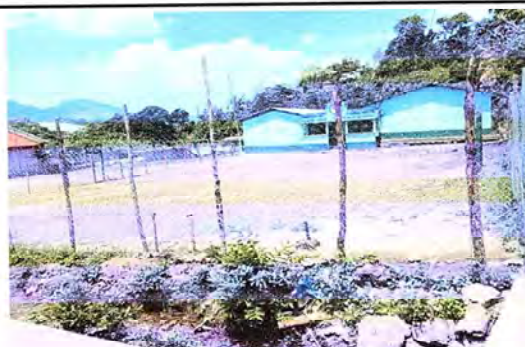
Foto 3: SUSTITUCIÓN AREA DE ENFRENTÉ
